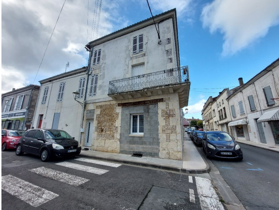
Travaux réalisés au sein d'un bâtiment existant à Matha. Crédit photographique : Citadia Conseil
